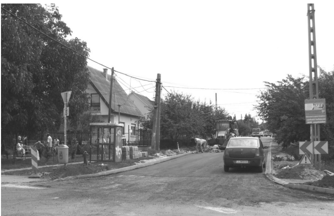
Az épülő Rákoskert sugárút
