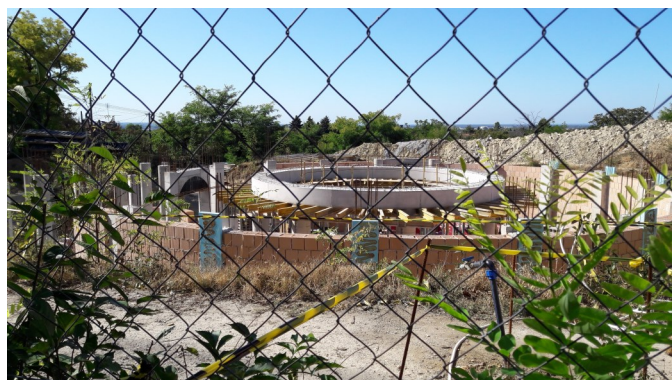
Az épülő Makovecz-templom
