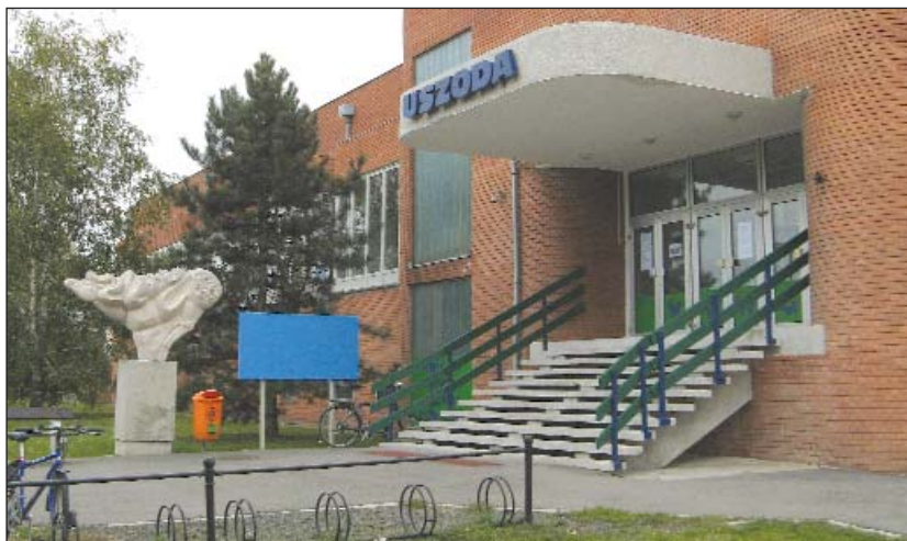
Az uszodát felújították, a biztonságot kamerák vigyázzák
