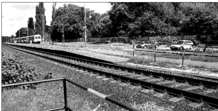
A rákoscsabai vasútállomás mellett is korszerű P+R parkoló fog épülni
