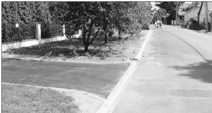
A felújított Rákosszabó utca
